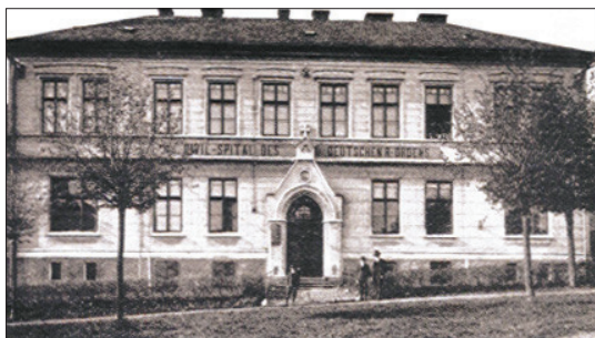
Obr. 63 Nemocnice Řádu německých rytířů ve Vrbně pod Pradědem, v současné době budova slouží jako Dětský domov u Speciální školy
