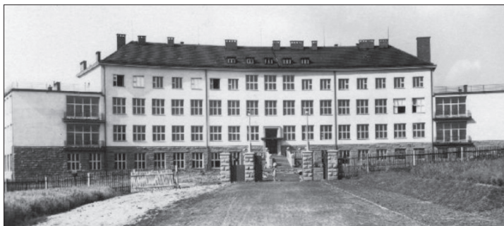
Obr. 75 Nemocnice ve Frýdku-Místku v roce 1937, pohled na nejstarší pavilon a vstupní bránu
